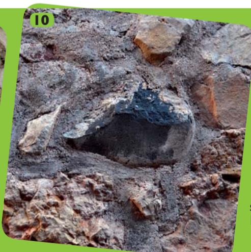
**9-** C'est un travertin ou tuf calcaire. Roche « bouche-trou » plus ou moins trouée et peu taillable. On y voit des traces de plantes et coquilles en calcaire. Son origine est une source pétrifiante chaude, il a **6 Ma**.
